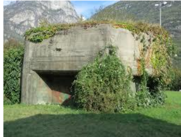
Bunker Grande Lodrino
